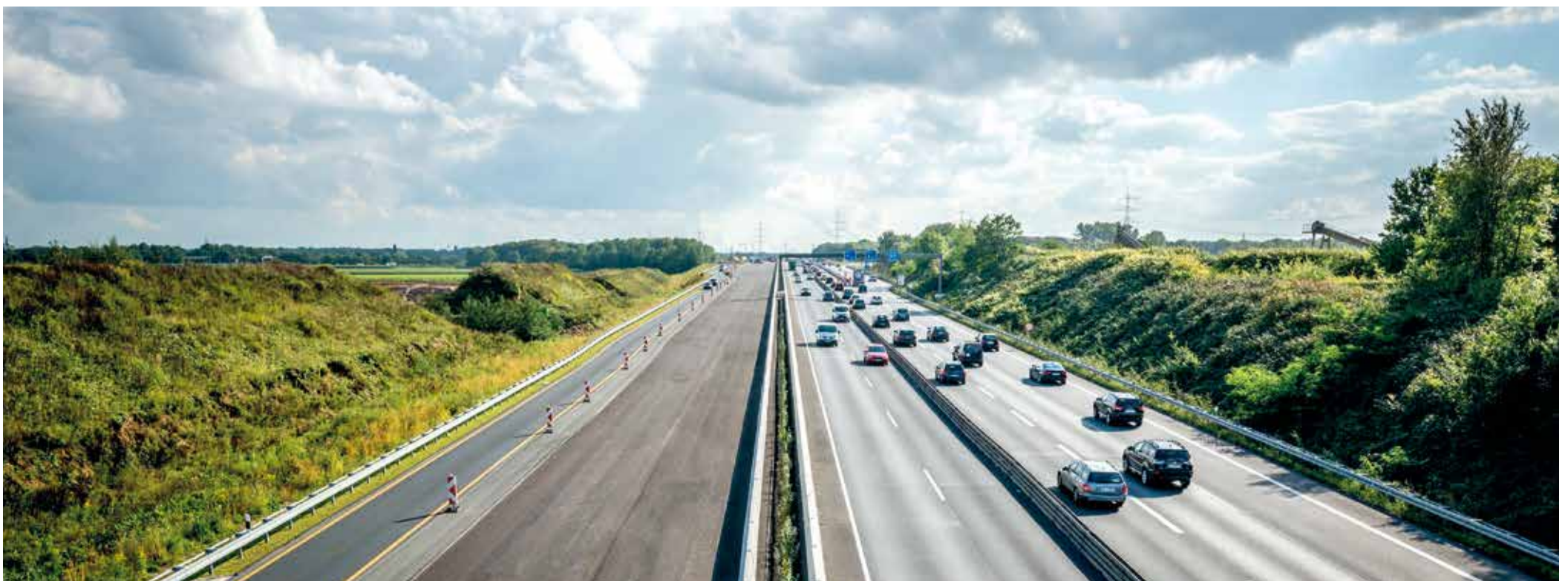
Endspurt auf der A57: Noch im Dezember 2015 wird der Verkehr auf dem Autobahnabschnitt zwischen Kaarst und Neuss-West wieder ungehindert rollen können.
