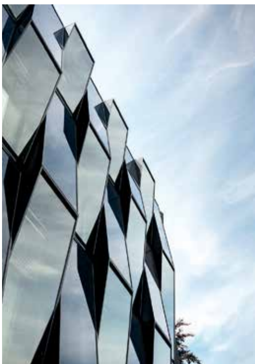
Photovoltaikmodule verleihen dem NEW-Blauhaus einen bläulichen Schimmer.
