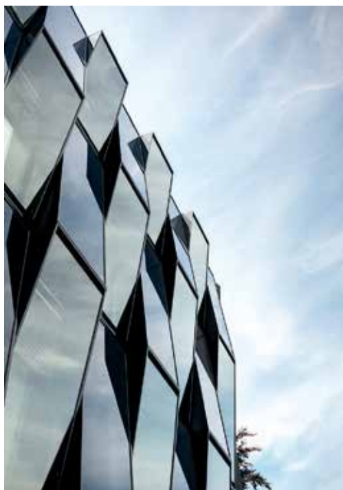
Photovoltaikmodule verleihen dem NEW-Blauhaus einen bläulichen Schimmer.
