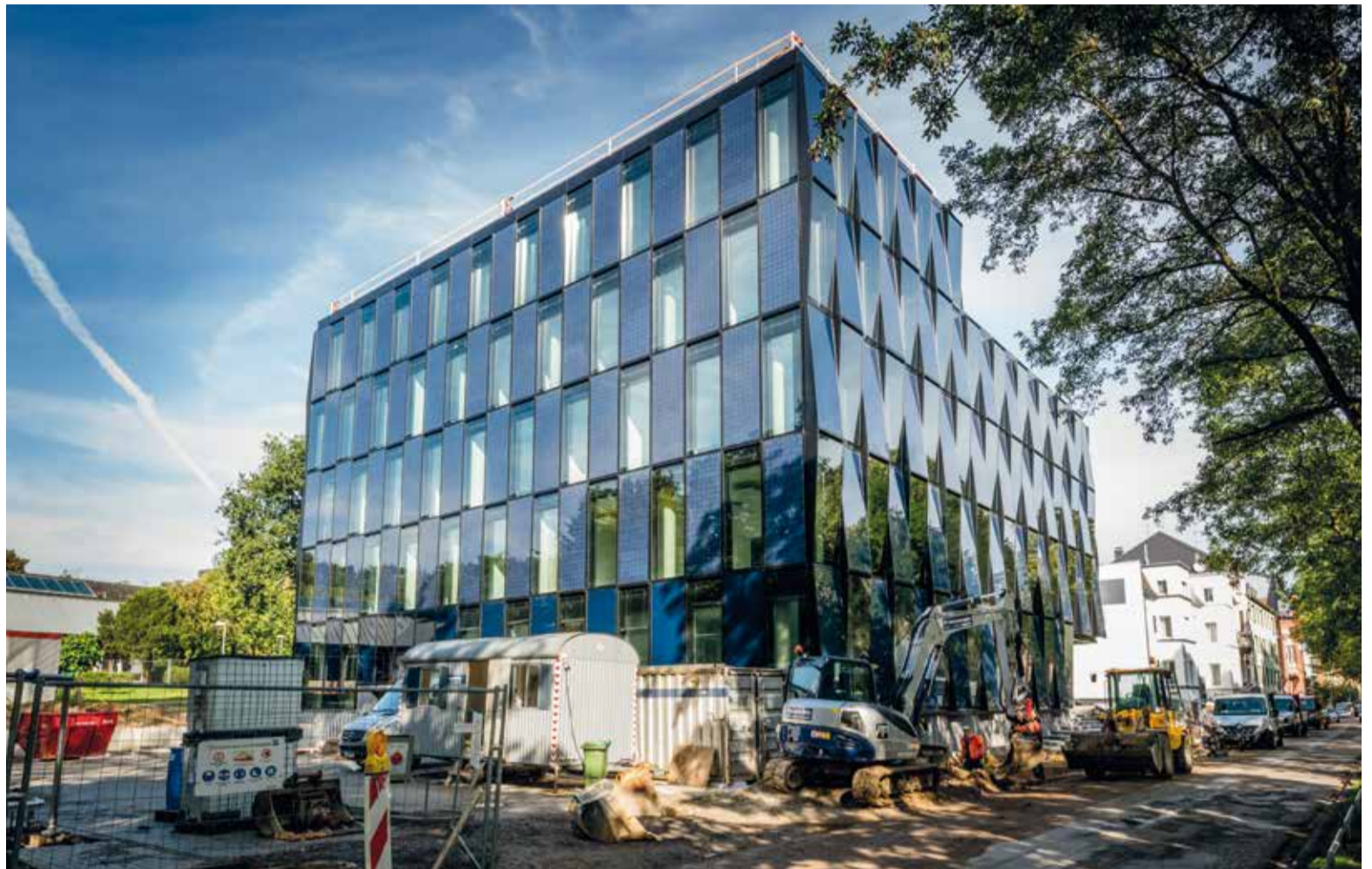
Meilenstein: das hochmoderne NEW-Blauhaus auf dem Campus der Hochschule Niederrhein in Mönchengladbach
